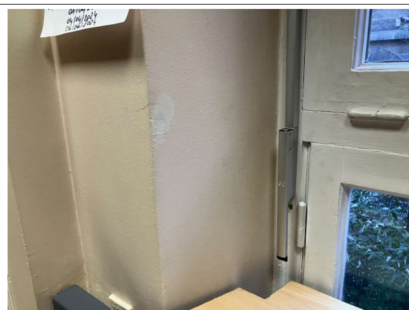
Prélèvement - P185 : Patio 2 / Entresol / Façade Est / Local 100/101/102/103 - Enduit- (Absence d'amiante)
