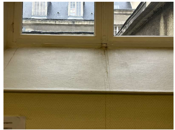
Prélèvement - P160 : Patio 2 / Entresol / Façade Sud / Local 105 - Enduit- (Présence d'amiante)
