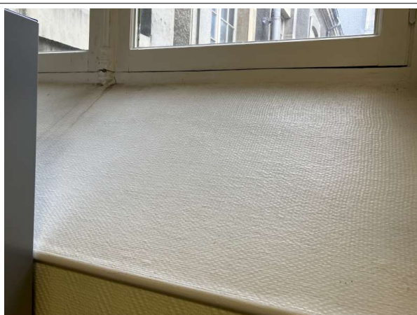
Prélèvement - P149 : Patio 2 / Entresol / Façade Sud / Local 168 - Enduit- (Absence d'amiante)
