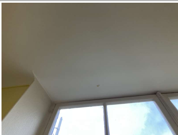
Prélèvement - P155 : Patio 2 / Entresol / Façade Sud / Local 168 - Enduit- (Présence d'amiante)
