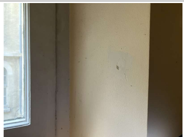
Prélèvement - P177 : Patio 2 / Entresol / Façade Est / Local 100/101/102/103 - Enduit- (Absence d'amiante)
