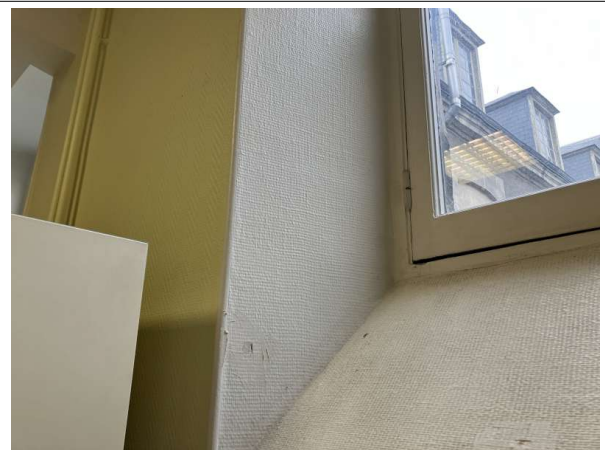
Prélèvement - P154 : Patio 2 / Entresol / Façade Sud / Local 168 - Enduit- (Absence d'amiante)
